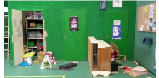
Dégradations et vols à la salle des sports.
