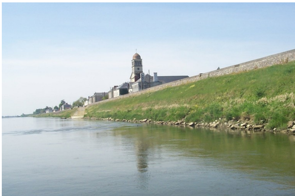
Levée de l'Authion à la Bohalle (photo DDE 49)
