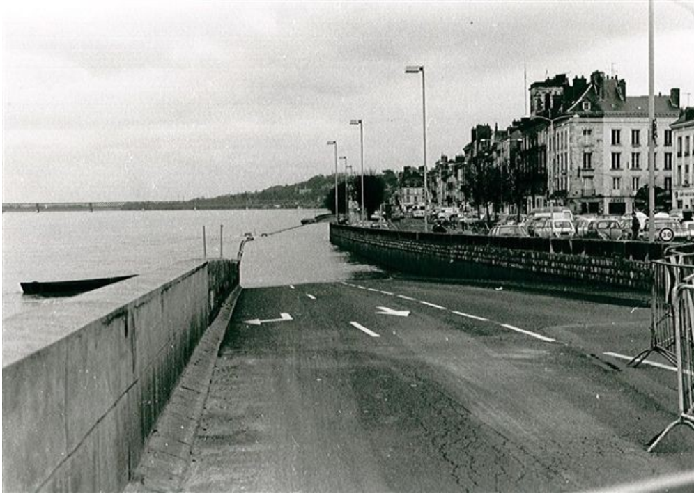
1994, Inondations à Saumur provoquant la fermeture de la RD 947 (photo DDT49)
