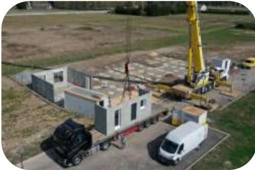
Ce concept, consiste à préparer en atelier des modules en béton pour le rez-de-chaussée et en bois pour l'étage.
